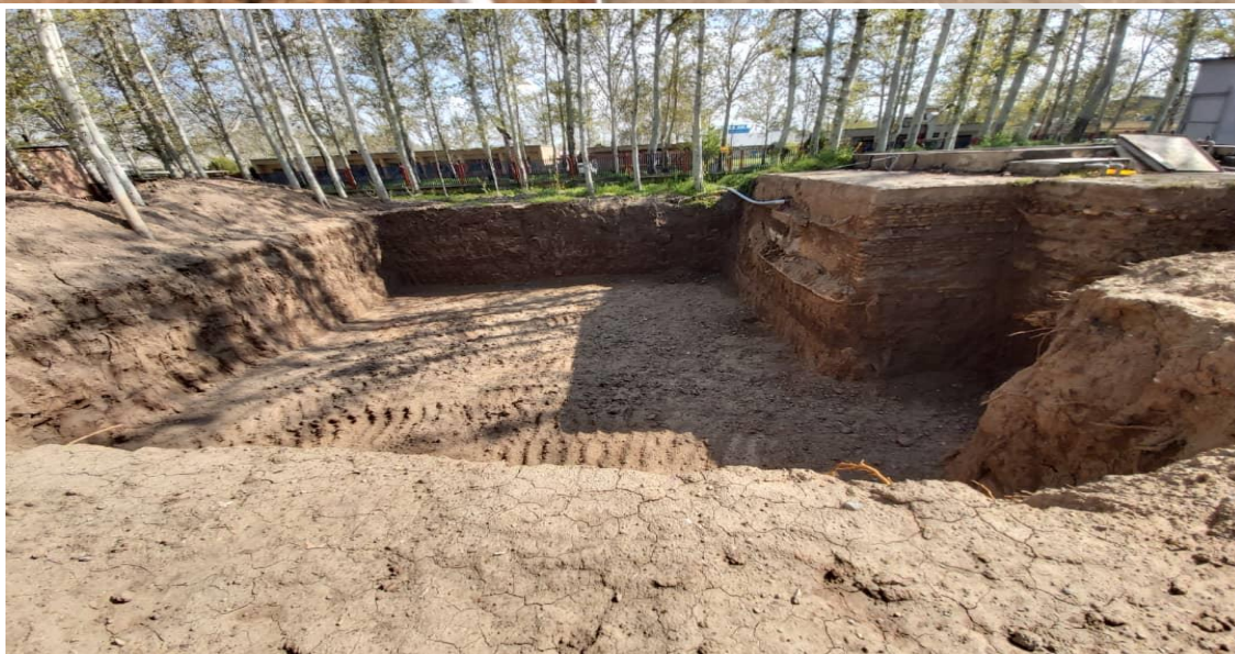
شکل ۱: نحوه ی حفر ترانشه جهت نصب مخزن
